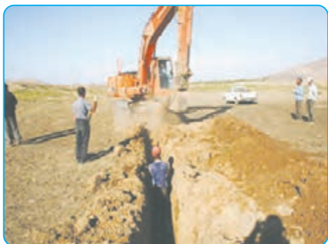
کندن زمین با بیل مکانیکی
