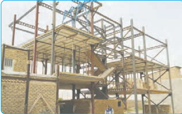
خانه‌ی در حال ساخت
